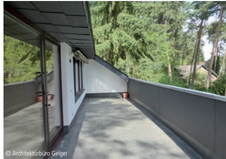
© Architekturbüro Geiger 6100-1150 Balkon (Mehrfamilienhaus) Instandsetzungen; Wohngebäude Architekturbüro Geiger Berlin
