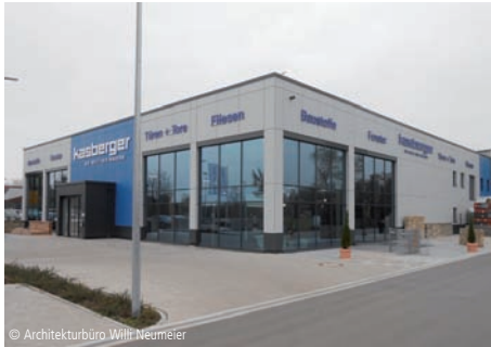
© Architekturbüro Willi Neumeier 7200-0088 Baufachmarkt, Ausstellungsgebäude Verbrauchermärkte
