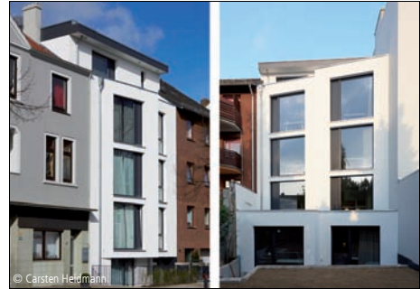
© Carsten Heidmann 6200-0068 Studentenwohnheim (14 WE) - Effizienzhaus 40 Wohnheime und Internate 🏠 360Grad / Architektur Bremen
