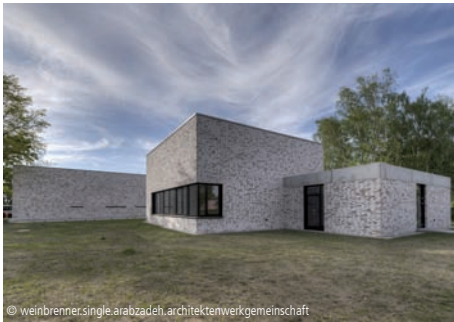
© weinbrenner.single.arabzadeh.architektenwerkgemeinschaft 5100-0104 Sporthalle (Dreifeldhalle), Therapiebereich Sporthallen (Dreifeldhallen)
