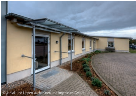
© Janiak und Lippert Architekten und Ingenieure GmbH 6200-0066 Tagesförderstätte (8 Pflegeplätze) Erweiterungen; Gebäude anderer Art Janiak und Lippert Architekten und Ingenieure GmbH Fockbek
