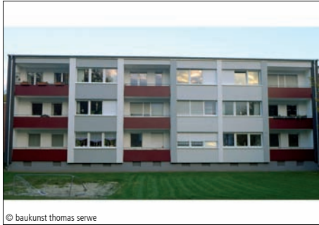
© baukunst thomas serwe 6100-1192 Mehrfamilienhaus (15 WE) Dachsanierung Modernisierungen; Wohngebäude nach 1945: Oberflächen baukunst thomas serwe Recklinghausen
