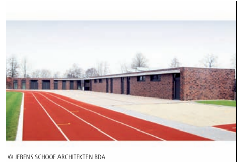
© JEBENS SCHOOF ARCHITEKTEN BDA 5300-0014 Sanitär- und Umkleidegebäude Sportbauten, sonstige
