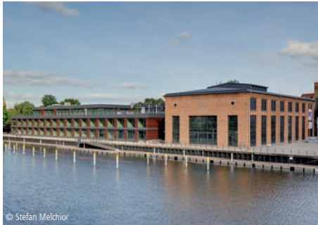
© Stefan Melchior 1300-0222 Bürogebäude (130 AP) Büro- und Verwaltungsgebäude, mittlerer Standard Dr. Krekler Generalplaner GmbH Brandenburg an der Havel
