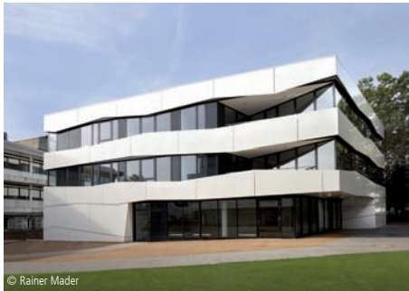
© Rainer Mader 1300-0219 Bürogebäude (72 AP) Hochschule Büro- und Verwaltungsgebäude, hoher Standard Heine, Wischer und Partner Freie Architekten GbR Köln
