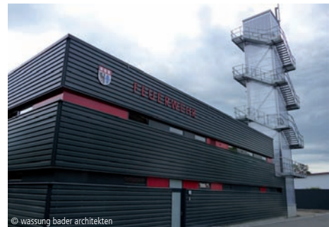
© wassung bader architekten 7600-0054 Feuerwehrhaus Feuerwehrhäuser
