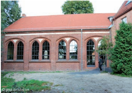
4100-0141 Grundschule (2 Klassen), Hort (90 Kinder) Umbauten; Schulen
