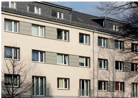
6100-1113 Wohn- und Geschäftshaus (21 WE) Instandsetzungen; Wohngebäude Mannott + Mannott Dipl. Ingenieure Architekten Hamburg
