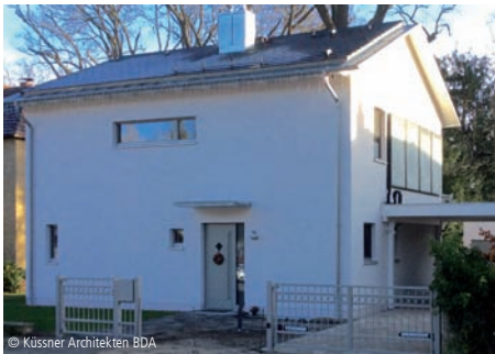
© Küssner Architekten BDA 6100-1247 Einfamilienhaus, Carport Ein- und Zweifamilienhäuser, unterkellert, hoher Standard Küssner Architekten BDA Kleinmachnow
