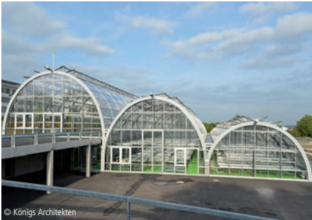
9400-0001 Forschungsgewächshaus Sonstige Gebäude
