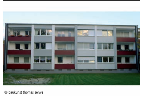
© baukunst thomas serwe 6100-1193 Mehrfamilienhaus (15 WE) Fassadensanierung Modernisierungen; Wohngebäude nach 1945: Oberflächen baukunst thomas serwe Recklinghausen
