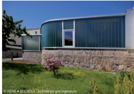
7700-0062 Mehrzweckhalle, Fahrradgeschäft Sonstige Gebäude
