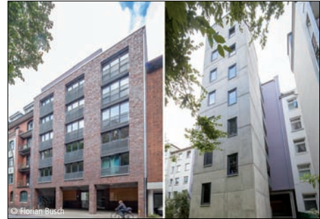
© Florian Busch 6100-1188 Mehrfamilienhaus (17 WE), barrierefrei Mehrfamilienhäuser, Passivhäuser
