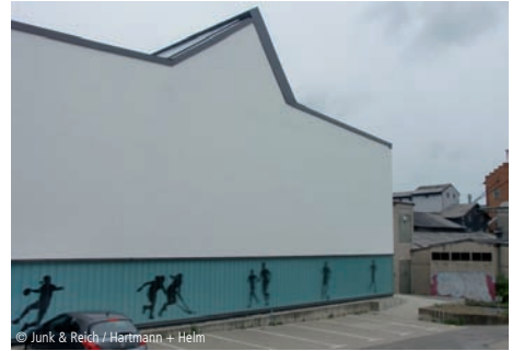
© Junk & Reich / Hartmann + Helm 5100-0077 Schulsporthalle (Dreifeldhalle) Instandsetzungen; Nichtwohngebäude ARGE GHS Ochsenfurt Junk & Reich / Hartmann + Helm, Weimar
