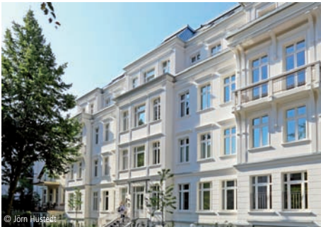
6100-1221 Mehrfamilienhaus (10 WE), TG - Passivhaus Mehrfamilienhäuser, Passivhäuser
