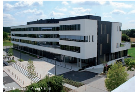
© Architekturbüro Georg Schmitt 1300-0223 Verwaltungsgeb. Schulungszentrum (330 AP) Büro- und Verwaltungsgebäude, mittlerer Standard Architekturbüro Georg Schmitt Darmstadt
