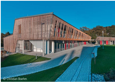
4300-0023 Sonderpädagogisches Förderzentrum Förder- und Sonderschulen ssp - planung GmbH Waldkirchen
