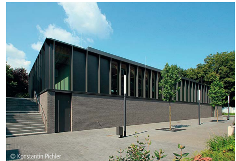
© Konstantin Pichler 6500-0044 Kantine (199 Sitzplätze) Effizienzhaus ~75% Gaststätten, Kantinen und Mensen Kastner Pichler Architekten Köln
