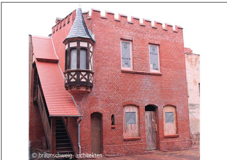
9900-0004 Ateliergebäude Instandsetzungen mit Restaurierungsarbeiten braunschweig. architekten Brandenburg
