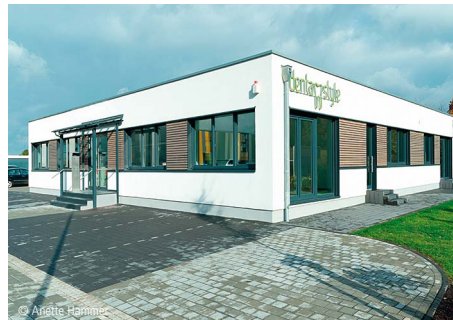
7100-0054 Laborgebäude (23 AP) Instituts- und Laborgebäude
