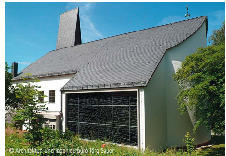
9100-0132 Evangelische Kirche, Sanierung Instandsetzungen; Nichtwohngebäude Architektur- und Ingenieurbüro Jörg Sauer Hildesheim
