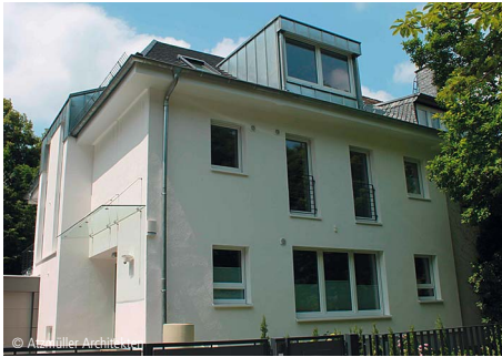
6100-1202 Stadtvilla Modernisierungen; Wohngebäude vor 1945 ☞ Atzmüller Architekten, Architekt Peter Atzmüller Frankfurt am Main
