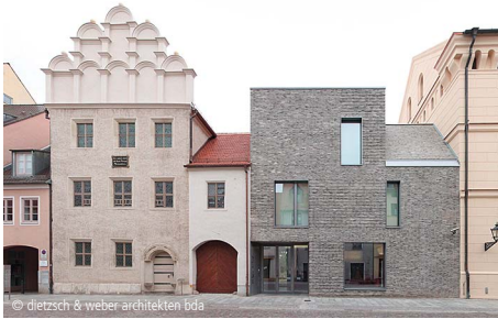
9100-0096 Museum Instandsetzungen mit Restaurierungsarbeiten dietsch & weber architekten bda Halle (Saale)
