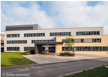
3200-0024 Notfall- und Diagnostikzentrum Eingangshalle Erweiterungen; sonstige Gebäude 🏠 Reichardt + Partner Architekten Hamburg
