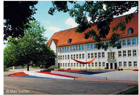
© Marc Stantier 4100-0171 Schulhof, Quartierspark Umbauten; Freianlagen zu Schulen KPN Architekten BDA Architektur + Freiraum Braunschweig
