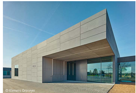
9100-0143 Aula Sonstige Gebäude Dohle + Lohse Architekten GmbH Braunschweig
