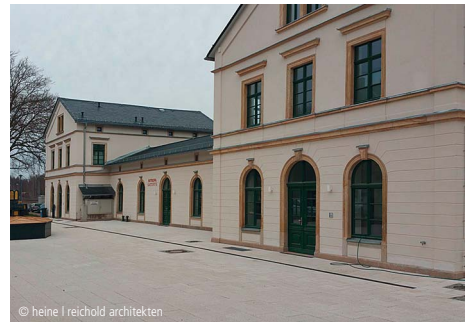
9100-0137 Vereinsgebäude, Schwammsanierung Instandsetzungen; Nichtwohngebäude heine I reichold architekten Partnerschafts- gesellschaft mbB, Lichtenstein
