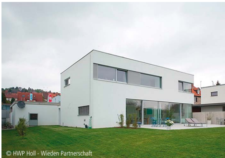
6100-1244 Einfamilienhaus, Doppelgar. - Effizienzhaus 70 Ein- u. Zweifamilienhäuser, nicht unterkell., mittl. Standard 🏠 HWP Holl - Wieden Partnerschaft Architekten & Stadtplaner, Würzburg
