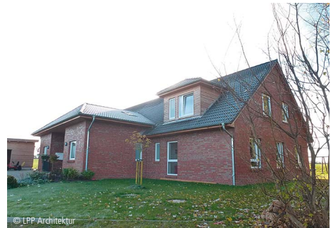
6200-0075 Wohnheim für Jugendliche - Effizienzhaus 70 Wohnheime und Internate 🏠 LPP Architektur Jens Lassen Eckernförde
