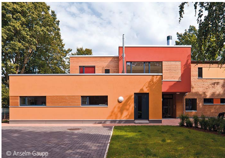
4400-0282 Kindertagesstätte (8 Gruppen, 140 Kinder) Kindergärten, Holzbauweise, nicht unterkellert Neustadtarchitekten (LPH1-5) mit lup-architekten (LPH 6-9), Hamburg
