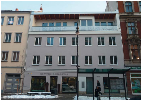
6100-1207 Wohn- und Geschäftshaus (5 WE) Modernisierungen; Wohngeb. n. 1945: m. Tragkonstruktion ☞ Märkplan Brandenburg
