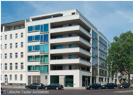
6100-1298 Mehrfamilienhaus (27 WE) - Effizienzhaus 70 Mehrfamilienhäuser, mit 20 oder mehr WE, hoher Standard 🏠 Liebscher-Tauber und Tauber Architekten Berlin
