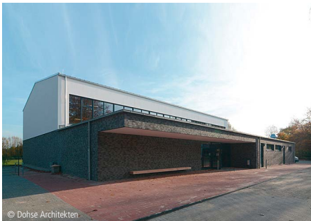
© Dohse Architekten 5100-0112 Sporthalle Sporthallen (Einfeldhallen) 🏠 Dohse Architekten Hamburg
