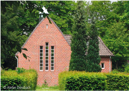
9100-0138 Veranstaltungsraum Instandsetzungen mit Restaurierungsarbeiten Atelier Donsbach Hamburg
