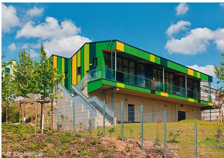
4400-0285 Kinderkrippe (3 Gr., 30 Ki.) - Effizienzhaus 85 Kindergärten, unterkellert AG: Architekten Naujack/Rind/Hof, Koblenz mit Baumeisteri Martin Maria Mertes, Saarbrücken
