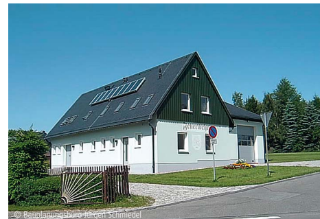
© Bauplanungsbüro Jürgen Schmiedel 7600-0074 Feuerwehrhaus Feuerwehrhäuser ☞ Bauplanungsbüro Jürgen Schmiedel Jöhstadt
