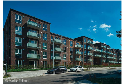
6100-1279 Mehrfamilienhaus (71 WE) - Effizienzhaus 70 Mehrfamilienhäuser, mit 20 oder mehr WE, mittl. Standard ☞ Dohse Architekten Hamburg
