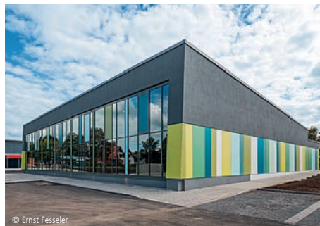
5100-0118 Sporthalle (1,5-Feldhalle) Sporthallen (Einfeldhallen)
