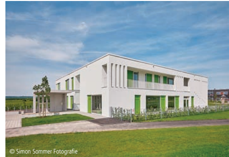
© Simon Sommer Fotografie 4400-0309 Kindertagesstätte - Effizienzhaus ~55% Kindergärten, nicht unterkellert, hoher Standard ZOLL Architekten Stadtplaner GmbH Stuttgart
