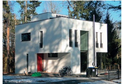
© wening.architekten 6100-1354 Einfamilienhaus - Effizienzhaus ~73% Ein- und Zweifamilienhäuser, unterkellert, hoher Standard wening.architekten Potsdam
