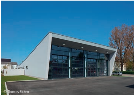
7600-0076 Feuerwehrgerätehaus - Passivhaus Feuerwehrrhäuser 🏠 Lengfeld & Wilisch Architekten PartG mbB Darmstadt
