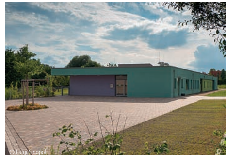
© Luigi Sinopoli 4400-0312 Kindertagesstätte (90 Ki.) - Effizienzhaus ~50% Kindergärten, nicht unterkellert, hoher Standard ARGE Kopf / Sinopoli Architekten Alzey
