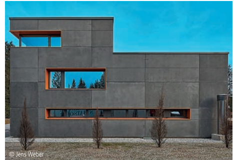
7600-0077 Seminargebäude, Fahrzeughalle Feuerwehrrhäuser 🏠 Schätzler | Architekten GmbH München
