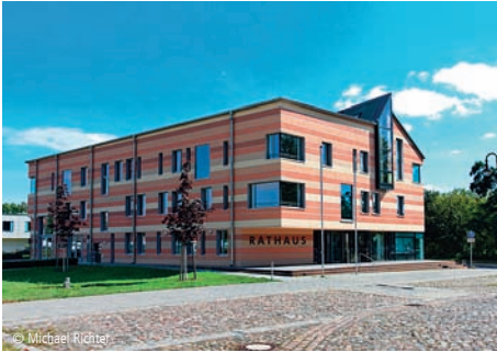
1300-0242 Rathaus (55 AP) - Passivhaus Büro- und Verwaltungsgebäude, mittlerer Standard ☞ Schmidtman und Gölling Architektur- und Ingenieurgesellschaft mbH, Berlin
