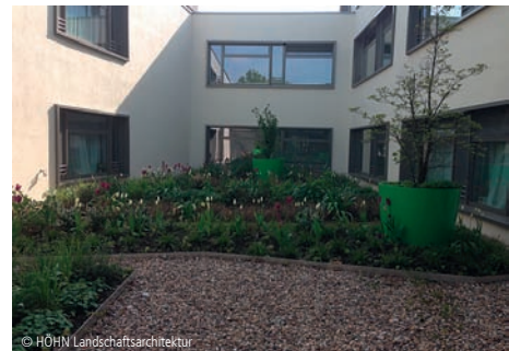
3200-0029 Dachbegrünung Krankenhaus Dachbegrünung HÖHN Landschaftsarchitektur Potsdam
