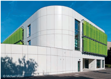
4100-0181 Grundschule (450 Sch.), Sporthalle - Passivhaus Allgemeinbildende Schulen
