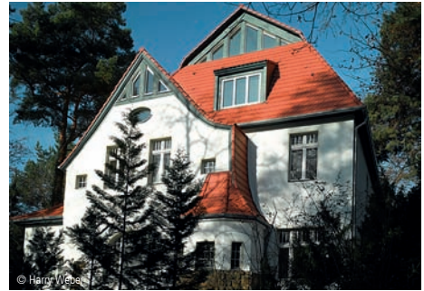
© Hans Weber 6100-1286 Mehrfamilienhaus, Dachgeschoss Erweiterungen; Wohngebäude: Dachausbau ☞ rundzwei Architekten Berlin
