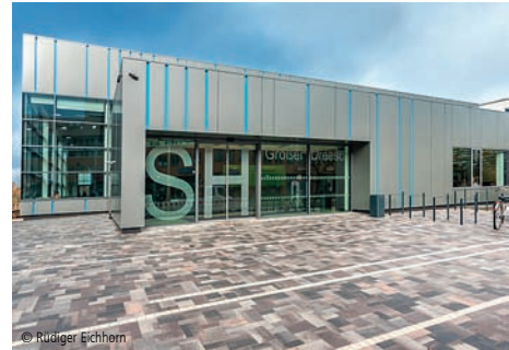
© Rüdiger Eichhorn 5200-0018 Schwimmhalle Schwimmhallen BAUCONZEPT® PLANUNGSGESELLSCHAFT mbH Lichtenstein/Sachsen
