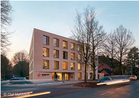
1300-0246 Bürogebäude (60 AP) - Effizienzhaus ~72% Büro- und Verwaltungsgebäude, mittlerer Standard ☞ kbg architekten bagge grothoff partner Oldenburg
