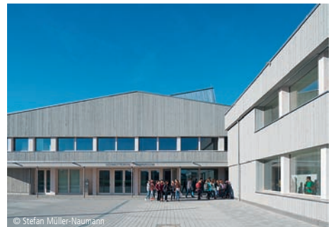
© Stefan Müller-Naumann 4100-0179 Gymnasium, Sporthalle - Plusenergiehaus Allgemeinbildende Schulen Hermann Kaufmann ZT GmbH & Florian Nagler Architekten GmbH "ARGE Diedorf", München
