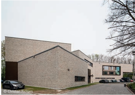
© Christian Richters 2200-0051 Lehrsaaalgebäude, Institut der Feuerwehr Instituts- und Laborgebäude behet bondzio lin architekten GmbH & Co.KG Münster
