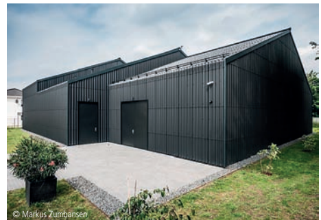
7700-0083 Lagerhalle Lagergebäude, ohne Mischnutzung 🏠 WÜRSCHINGER Architekten GmbH Berlin
