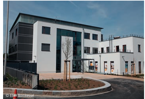
© Ellen Bornkessel 3100-0029 Praxis-, Labor- und Bürogebäude Medizinische Einrichtungen Architekturwerkstatt Bornkessel Hammelburg
