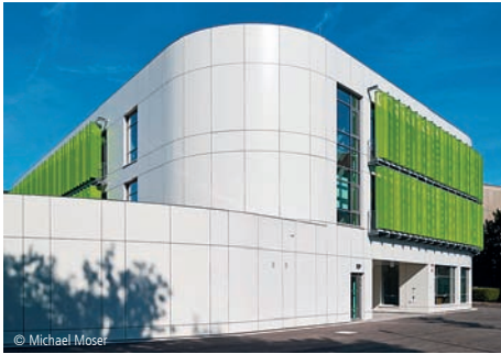
4100-0181 Grundschule (450 Sch.), Sporthalle - Passivhaus Allgemeinbildende Schulen pbr Planungsbüro Rohling AG Braunschweig
