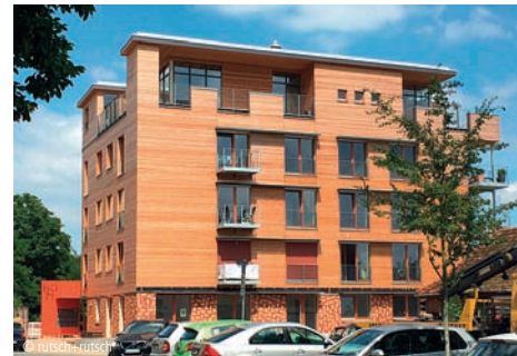
6100-1372 Mehrfamilienhaus (12 WE) - Effizienzhaus 70 Umbauten; Mehrfamilienhäuser rutsch+rutsch architektur+szenografie Schwerin
