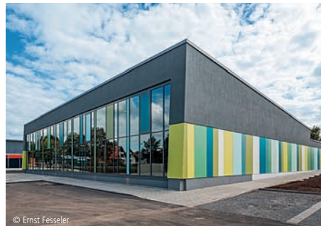
5100-0118 Sporthalle (1,5-Feldhalle) Sporthallen (Einfeldhallen)
