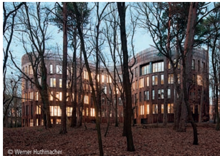
2200-0050 Forschungsgebäude, Rechenzentrum (215 AP) Instituts- und Laborgebäude ☐ BHBVT Gesellschaft von Architekten mbH Berlin
