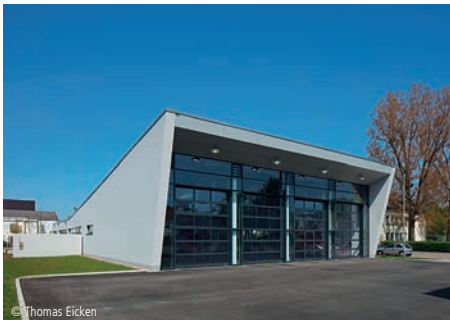
© Thomas Eicken 7600-0076 Feuerwehrgerätehaus - Passivhaus Feuerwehrhäuser ☞ Lengfeld & Wilisch Architekten PartG mbB Darmstadt
