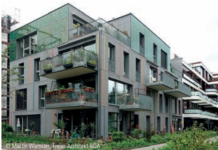
© Martin Wamsler, Freier Architekt BDA 6100-1186 Mehrfamilienhaus (9 WE) - Effizienzhaus Plus Mehrfamilienhäuser, mit 6 bis 19 WE, mittlerer Standard Martin Wamsler Freier Architekt Friedrichshafen
