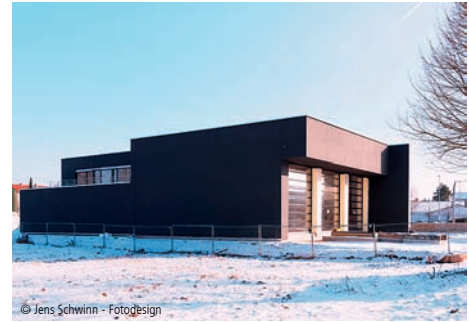
© Jens Schwinn - Fotodesign 7600-0075 Feuerwehrgerätehaus - Effizienzhaus 70 Feuerwehrhäuser ☞ Eis Architekten GmbH Bamberg
