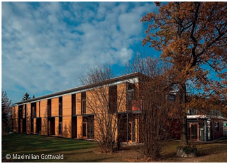
© Maximilian Gottwald 4400-0265 Kinderkrippe (6 Gruppen, 72 Kinder) Kindergärten, Holzbauweise, nicht unterkellert ABHD Architekten Beck und Denzinger Neuburg a.d. Donau
