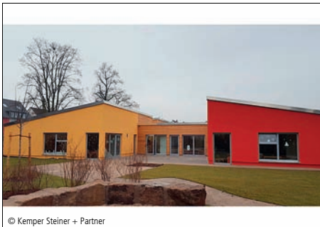
© Kemper Steiner + Partner 4400-0310 Kindergarten (80 Ki.) - Effizienzhaus ~76% Kindergärten, Holzbauweise, nicht unterkellert Kemper Steiner & Partner Architekten GmbH Bochum
