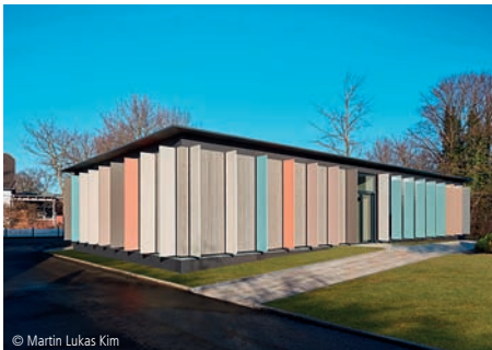
© Martin Lukas Kim 5200-0017 Bewegungsbad Schwimmhallen JEBENS SCHOOF ARCHITEKTEN BDA Heide
