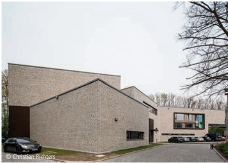
© Christian Richters 2200-0051 Lehrsaaelgebäude, Institut der Feuerwehr Instituts- und Laborgebäude behet bondzio lin architekten GmbH & Co.KG Münster
