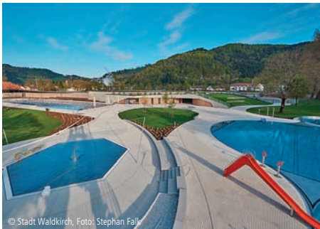
© Stadt Waldkirch, Foto: Stephan Falz 5200-0013 Freibad Umbauten; sonstige Gebäude Kauffmann Theilig & Partner Freie Architekten BDA Ostfildern
