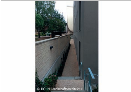
3200-0030 Grundstücksmauer Krankenhaus Freianlagen zu Medizinischen Einrichtungen HÖHN Landschaftsarchitektur Potsdam
