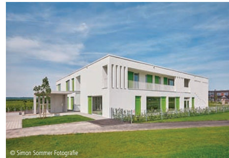
© Simon Sommer Fotografie 4400-0309 Kindertagesstätte - Effizienzhaus ~55% Kindergärten, nicht unterkellert, hoher Standard ZOLL Architekten Stadtplaner GmbH Stuttgart
