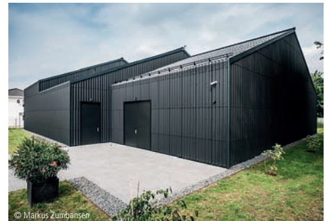
© Markus Zumbansen 7700-0083 Lagerhalle Lagergebäude, ohne Mischnutzung ☞ WÜRSCHINGER Architekten GmbH Berlin
