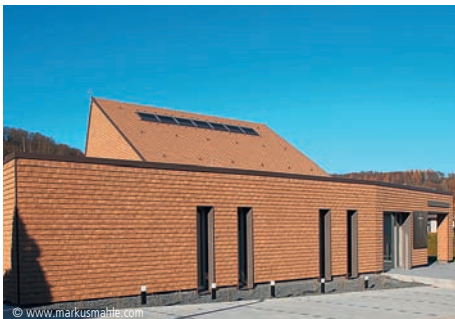
9100-0160 Neuapostolische Kirche Sakralbauten Bodamer Faber Architekten BDA Stuttgart
