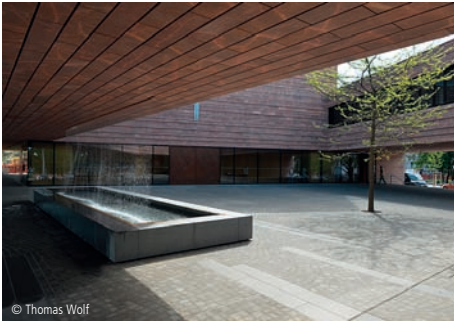
© Thomas Wolf 9100-0146 Freianlage Probsteikirche Freianlagen zu Kirchen r + b landschaft s architektur Dresden
