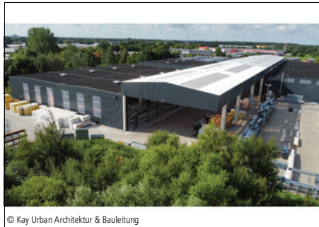
7700-0094 Lagerhalle, überdachte Ladezone Lagergebäude, ohne Mischnutzung
