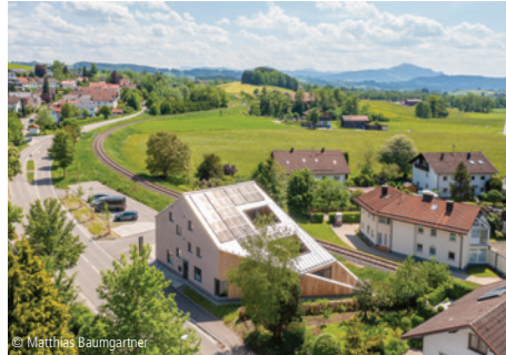
6100-1653 Außenanlage Mehrfamilienhaus, Praxis (16 STP) Außenanlagen zu Mehrfamilienhäusern brack architekten Kempten
