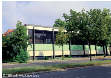
5100-0139 Sporthalle, Halleninnenraum, Gebäudehülle Modernisierungen; Sporthallen TSSB architekten.ingenieure Berlin
