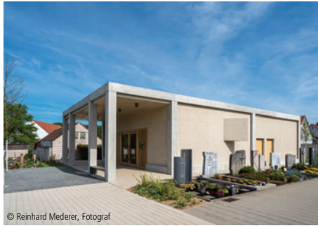
9700-0033 Aussegnungshalle (80 Sitzplätze) Friedhofsgebäude
