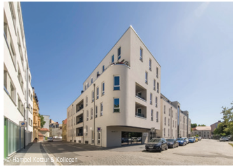
6100-1648 Mehrfamilienhaus (33 WE), TG (30 STP) Mehrfamilienhäuser, mit 20 oder mehr WE, mittl. Standard Hempel Kotzur & Kollegen Architekten und Ingenieure Cottbus
