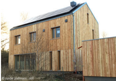
6100-1698 Mehrfamilienhaus (2 WE) Mehrfamilienhäuser, Holzbauweise sunder plaßmann . noll Kassel
