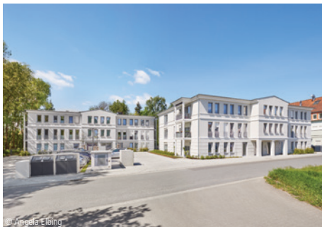
6200-0128 Seniorenwohnanlage (2 Gebäude, 36 WE) Seniorenwohnungen, mittlerer Standard
