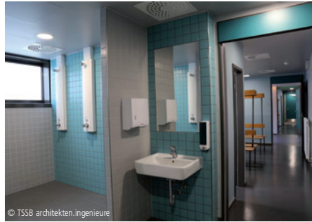
5100-0132 Sporthalle, Sozialtrakt, Innenbereich Modernisierungen; Sporthallen TSSB architekten.ingenieure Berlin
