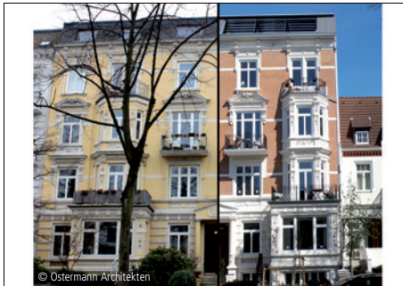
6100-1502 Mehrfamilienhaus, Schwammsanierung Instandsetzungen; Schwammsanierung Ostermann Architekten Hamburg
