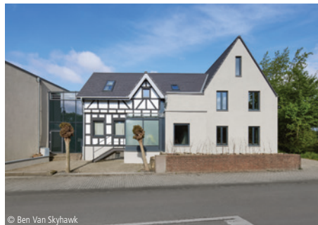
6100-1631 Mehrfamilienhaus (2 WE) Ein- u. Zweifamilienhäuser, nicht unterkell., mittl. Standard Wendling Architektur Köln-Deutz
