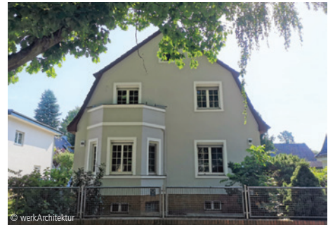
6100-1599 Zweifamilienhaus Instandsetzungen; Wohngebäude werkArchitektur Berlin
