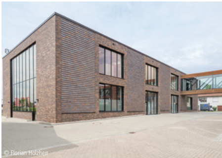
7100-0074 Produktionshalle (22 AP) Industrielle Produktionsgebäude, überwiegend Skelettbau K + H Architekten PartG mbB Hildesheim
