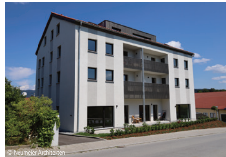
6100-1637 Außenanlage Mehrfamilienhaus (11 STP) Außenanlagen zu Mehrfamilienhäusern Neumeier Architekten PartGmbH Tittling
