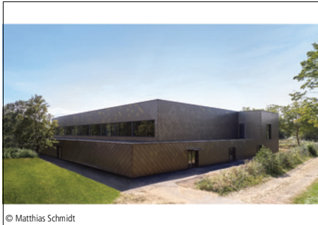
5100-0142 Mehrzweckhalle (540 Sitzplätze) Sport- und Mehrzweckhallen
