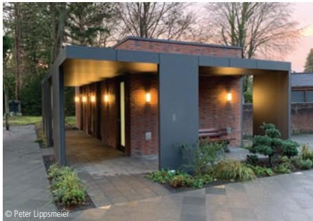
9900-0007 Toilettenanlage Ohne Gebäudeartenzuordnung Gütig Architektur Bornheim-Hersel
