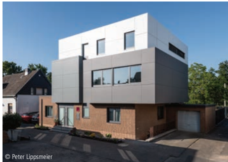
6100-1746 Einfamilienhaus Aufstockung Erweiterungen; Wohngebäude: Aufstockung Gütig Architektur Bornholm-Hersel
