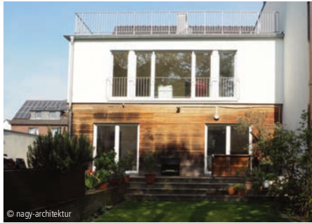
6100-1731 Anbau Einfamilienhaus Erweiterungen; Wohngebäude: Anbau nagy-architektur Köln
