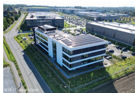
1300-0325 Verwaltungsgebäude (90 AP) Büro- und Verwaltungsgebäude, mittlerer Standard NEXT Bielefeld GmbH Bielefeld
