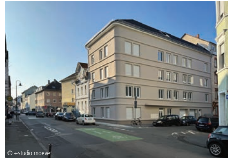
6100-1711 Mehrfamilienhaus (7 WE), Doppelgarage Mehrfamilienhäuser, mit 6 bis 19 WE, mittlerer Standard +studio moeve Planungsbüro dba GmbH & Co. KG Darmstadt
