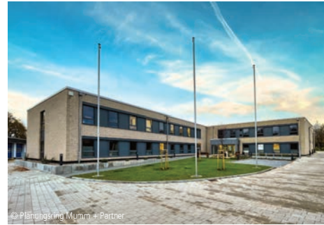
1300-0319 Amtsverwaltung (36 AP) Büro- und Verwaltungsgebäude, mittlerer Standard Planungsring Mumm + Partner GbR Treia
