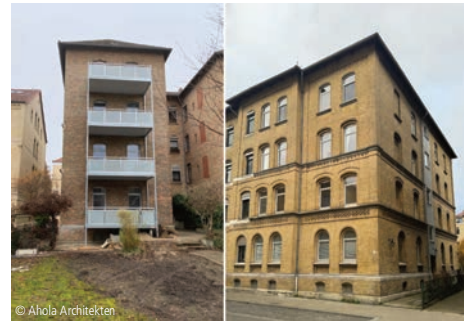
6100-1753 Mehrfamilienhaus (8 WE) Instandsetzungen; Wohngebäude Ahola Architekten Braunschweig
