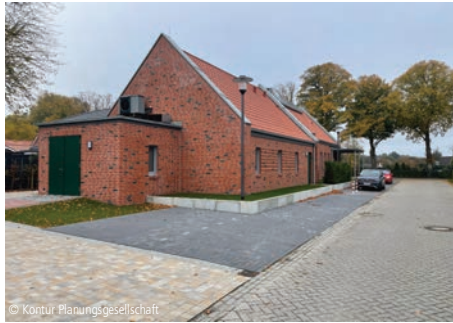
9700-0037 Trauerzentrum Friedhofsgebäude Kontur Planungsgesellschaft mbH, Oldenburg und Leinau6 GbR, Hannover
