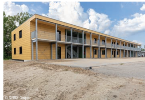
6200-0136 Übergangswohnheim (120 Betten) Wohnheime und Internate Dienstleistungsbetrieb Stadt Xanten und W. u. J. Derix GmbH & Co., Niederkrüchten
