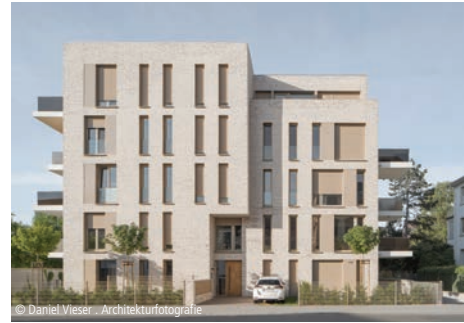
6100-1701 Mehrfamilienhaus (18 WE), TG Mehrfamilienhäuser, mit 6 bis 19 WE, mittlerer Standard P4_ARCHITEKTEN BDA Frankenthal
