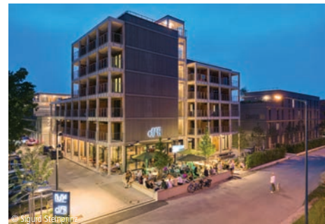
6600-0039 Boardinghouse Hotels ACMS Architekten GmbH Wuppertal
