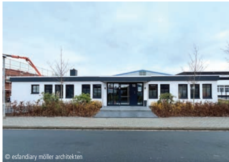
1300-0329 Bürogebäude (8 AP) Modernisierungen; Büro- und Verwaltungsgebäude esfandary möller architekten PartG mbB Lüneburg
