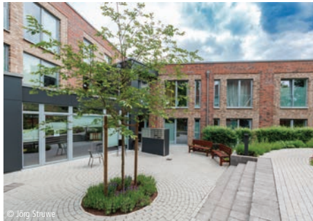
6100-1725 Mehrfamilienhaus (31 W), TG Mehrfamilienhäuser, mit 20 oder mehr WE, hoh. Standard 🏠 schüch & cassau architekten bda + beratender Ingenieur PartGmbH, Stade
