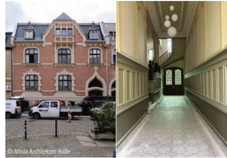
6100-1733 Mehrfamilienhaus (11 WE) Instandsetzungen; Wohngebäude Ahola Architekten Halle Halle
