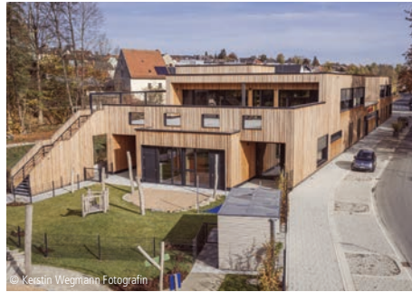
4400-0408 Kinderhaus (6 Gruppen, 174 Kinder) Kindergärten, Holzbauweise, nicht unterkellert HILGARTH Architekten-Stadtplaner Marktreidwitz
