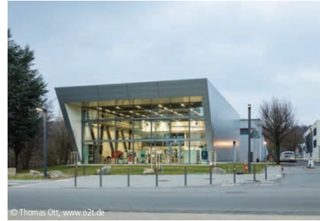
2200-0070 Produktions-/Forschungshalle Industrielle Produktionsgebäude, überwiegend Skelettbau pwpMAS Architekten PartG mbB Darmstadt
