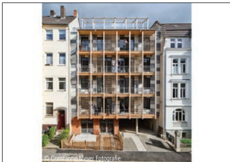
6100-1772 Mehrfamilienhaus (9 WE, 3 STP)
