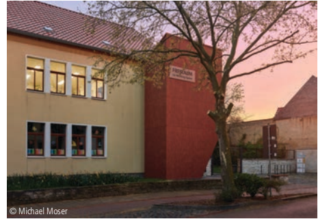
1300-0324 Gründerzentrum (20 AP) Umbauten; Büro- und Verwaltungsgebäude Liebnerstadtfeld Architekten Magdeburg
