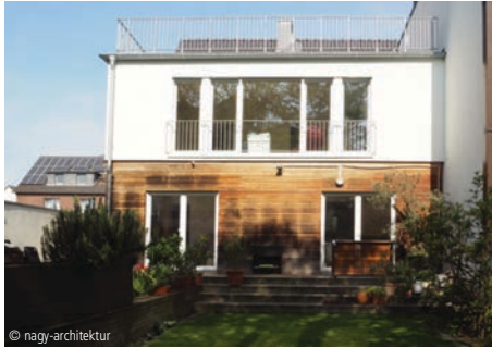
6100-1731 Anbau Einfamilienhaus Erweiterungen; Wohngebäude: Anbau nagy-architektur Köln
