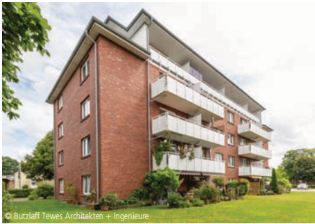
6100-1729 Mehrfamilienhaus (29 WE) Mehrfamilienhäuser, mit 20 oder mehr WE, mittl. Standard Butzlaff Tewes Architekten + Ingenieure Brande-Hörnerkirchen
