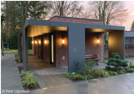
9900-0007 Toilettenanlage Sonstige Gebäude Gütig Architektur Bornheim-Hersel
