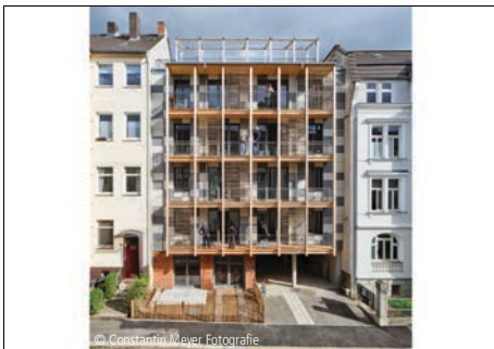
6100-1772 Mehrfamilienhaus (9 WE, 3 STP)
