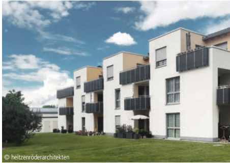
6100-1755 Mehrfamilienhaus (12 WE) Mehrfamilienhäuser, mit 6 bis 19 WE, mittlerer Standard heizenröderarchitekten GmbH Hanau
