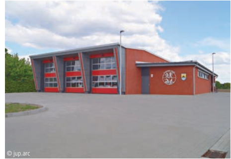
7600-0085 Feuerwehrhaus (3 Fahrzeuge) Feuerwehrhäuser jup.arc weinert juraschek architekten partmbb Winsen (Luhe)
