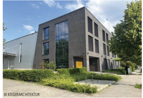
7700-0098 Konfektionierungslagerhalle, Büros Betriebs- u. Werkstätten, mehrgeschossig, hoh. Hallenanteil KISSERARCHITEKTUR Isernhagen
