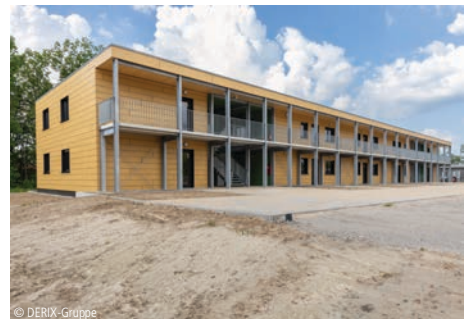
6200-0136 Übergangswohnheim (120 Betten) Wohnheime und Internate Dienstleistungsbetrieb Stadt Xanten und W. u. J. Derix GmbH & Co., Niederkrüchten
