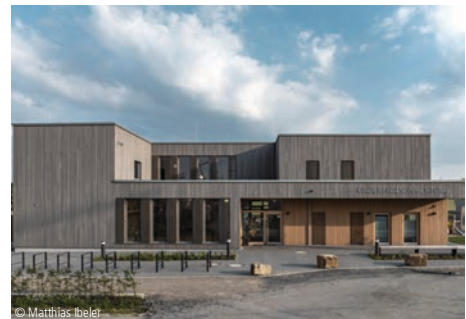
4400-0403 Kindertagesstätte (75 Kinder) Kindergärten, Holzbauweise, nicht unterkellert abdelkader architekten bda Partnerschaft mbB Münster
